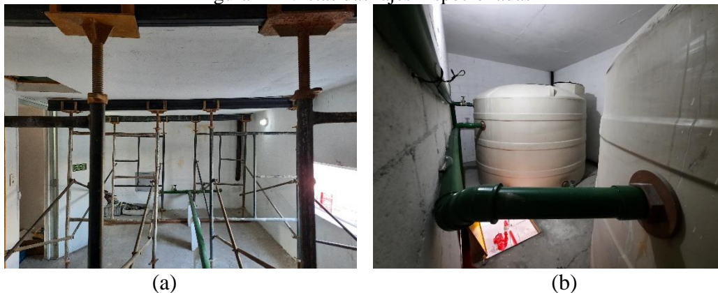
Figura 2 – Vistas das lajes inspecionadas
