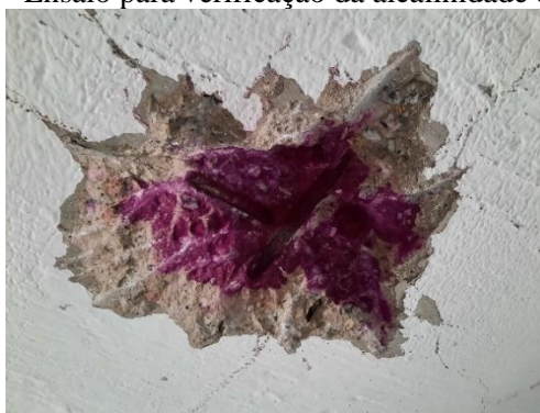
Figura 10 – Ensaio para verificação da alcalinidade do concreto
